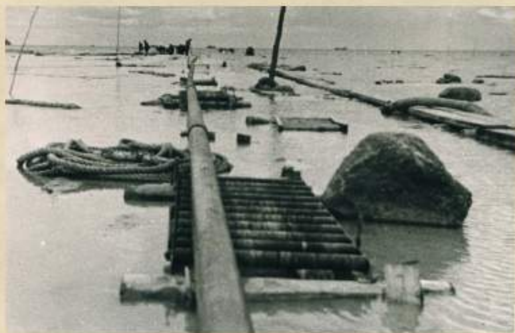
Укладка трубопровода по дну Ладожского озера (фото из личного архива А.В.Хрулева)
